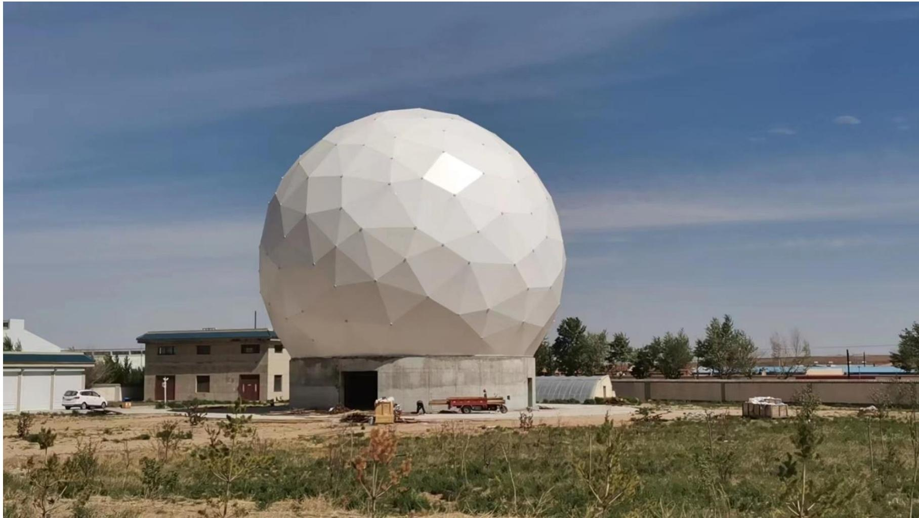
乌兰察布站三频段收发双工极化复用天线——天线罩直径25米
